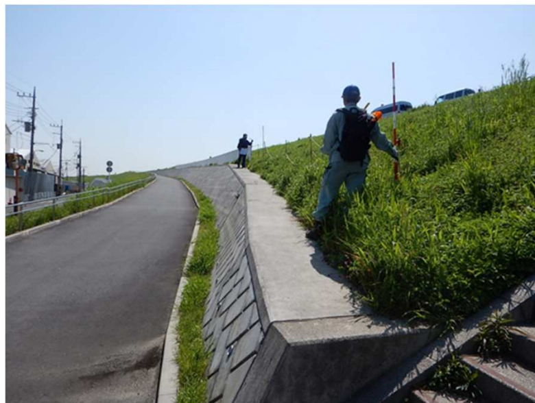
堤防における危険箇所の有無を点検中
