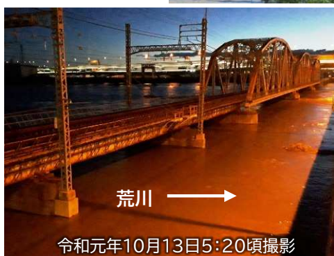
令和元年東日本台風時の状況
