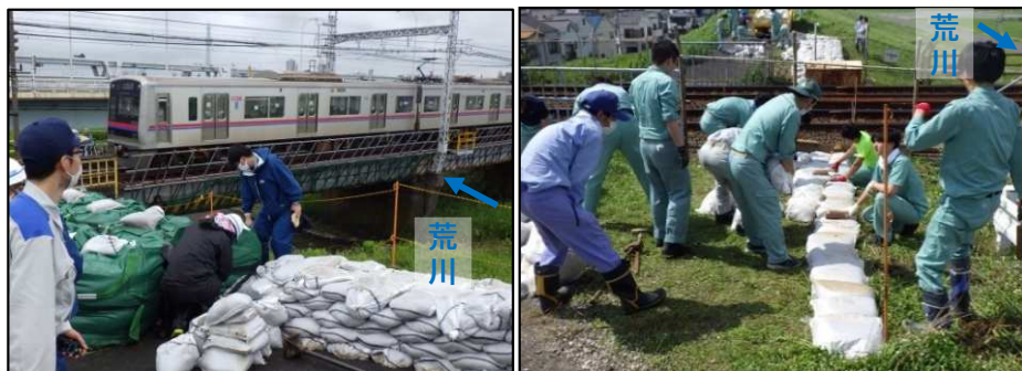
▲ 荒川左岸(葛飾区側)土のう設置状況
