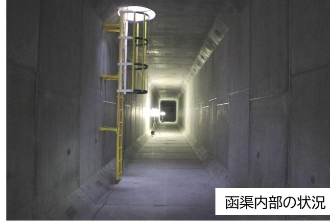
これまで自然流下の雨水管により雨水対策を実施してきましたが、排水先である排水路の影響により浸水被害が発生してきました。その対策として貯留函渠を整備し、貯留函渠に貯水した雨水は排水先である排水路の水位が下がりしだいポンプが稼働するよう制御されています。
