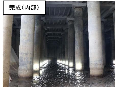
三郷中央地区の開発に伴い、市開発条例及び埼玉県の雨水流出抑制施設の条例に基づいた「新和調整池」。大雨時には最大約13,500m<sup>3</sup>を貯留する、東西に約50m、南北に約40mの地下調整池である。
