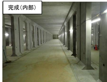
松原団地建替事業に伴い、市開発条例及び埼玉県雨水流出条例に基づいた雨水流出抑制施設を整備した。大雨時には最大約10,500m<sup>3</sup>を貯留する、東西に約76m、南北に約37mの地下貯留施設である。
