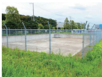
地表面貯留施設
