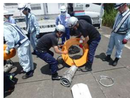
ポンプの組立
