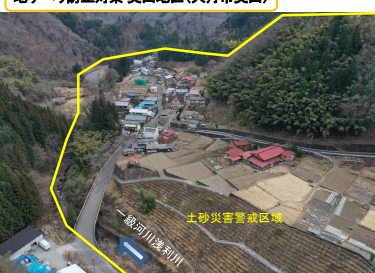
地すべり防止対策 奥山地区(大月市奥山)
