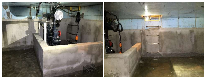
地下貯留施設
