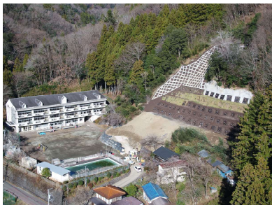
完成状況 (令和4年12月)
