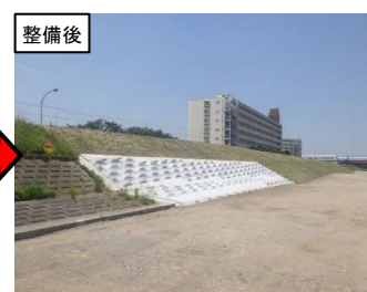
多摩川右岸20.2k付近(平成30年5月完成)
