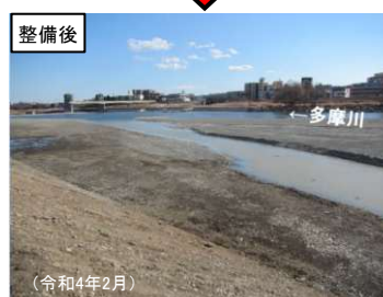
河道掘削 多摩川宿河原堰上流(令和4年2月完了)
