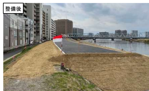
築堤 多摩川右岸5.8k周辺 (令和3年1月完成)
