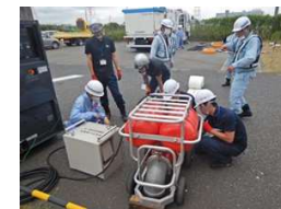
小型移動式排水設備講習状況
