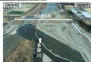
大丸用水堰改築工事状況（令和6年1月末現在）
