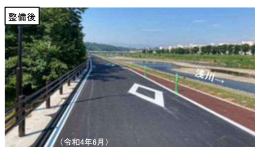
築堤 浅川左岸5.6k周辺 (令和4年6月完成)
