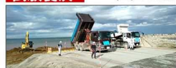
養浜材の荷下・投入状況 (R4.8.18 撮影)
