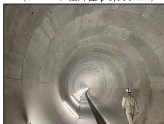
雨水貯留管内部 (仕上がり内径φ5,250mm)
