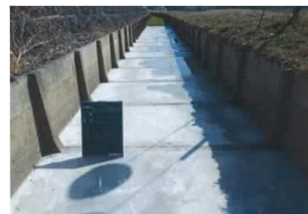
底張りコンクリート
