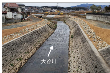
広島県による支川の改修 大谷川
