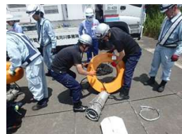
ポンプの組立
