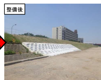
多摩川右岸20.2k付近(平成30年5月完成)
