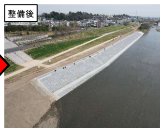
多摩川左岸17.0k付近(令和4年3月月完成)
