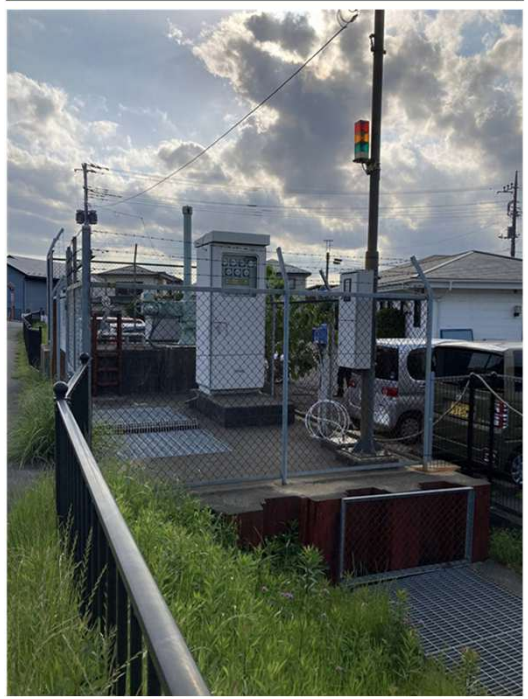
樋之口橋排水ポンプ場
