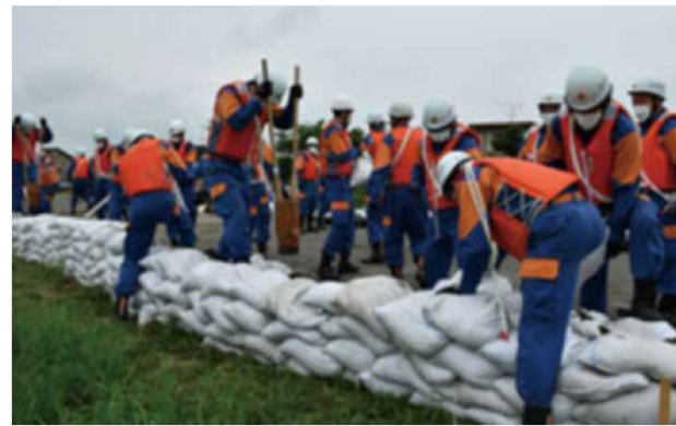
水防訓練(積み土のう工)
