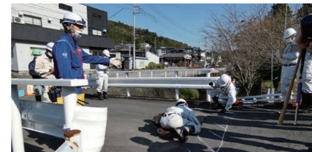
直営点検に向けた模擬点検(東京都青梅市内)
