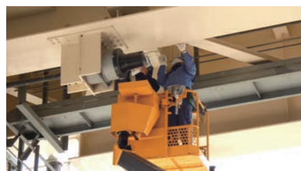
橋梁の健全性診断の様子
