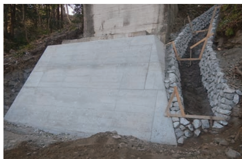
浸食箇所の対策と水路の設置
