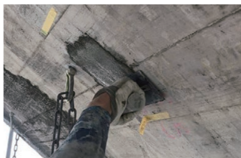
コンクリートの補修
