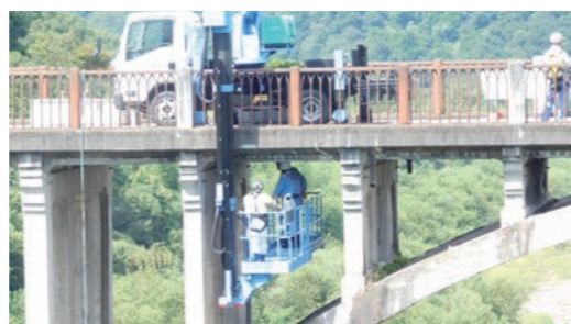
秩父橋(埼玉県秩父市)における直轄診断の様子
