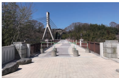
修繕代行完了後の様子
