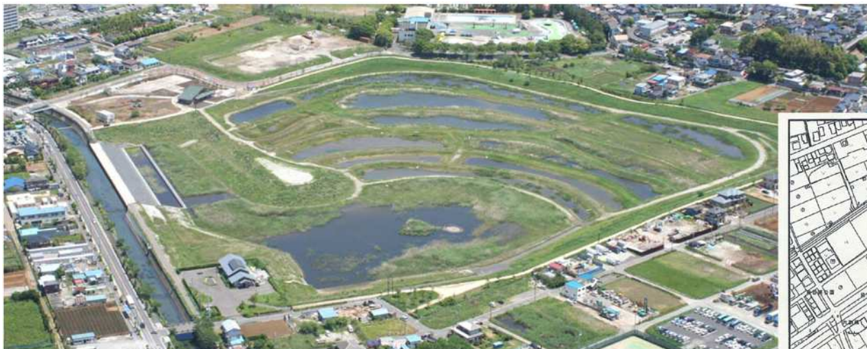
大柏川第一調節池
