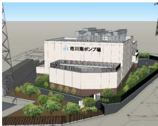
市川南ポンプ場イメージ(建設中)
