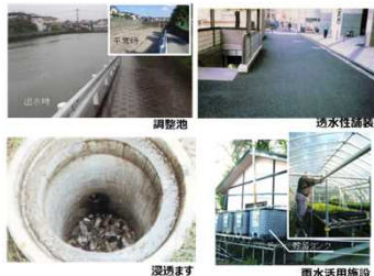
雨水貯留浸透施設の例
