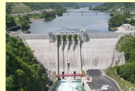
＜完成したハッ場ダム＞
