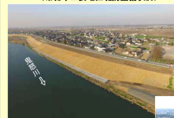
<常総市三妻地区堤防整備状況>
