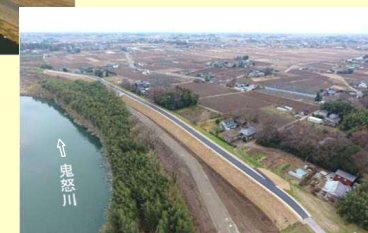
<八千代町坪井地区堤防整備状況>
