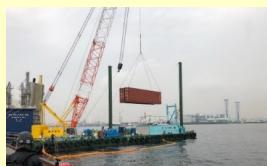
海底障害物の撤去
