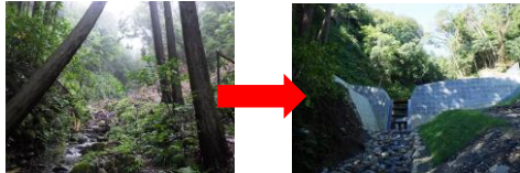
安居山沢右支川 砂防堰堤 (静岡県)
