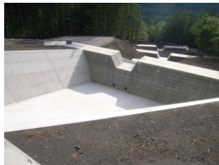
塩島沢堰堤群(富士川砂防事務所)
