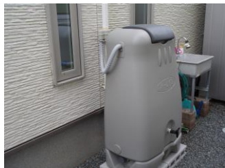
貯留槽の整備事例(富士市)
