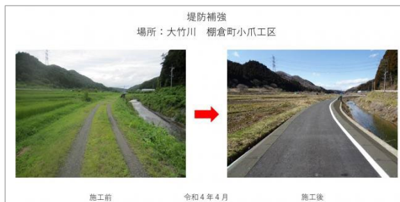
（堤防補強 福島県）
