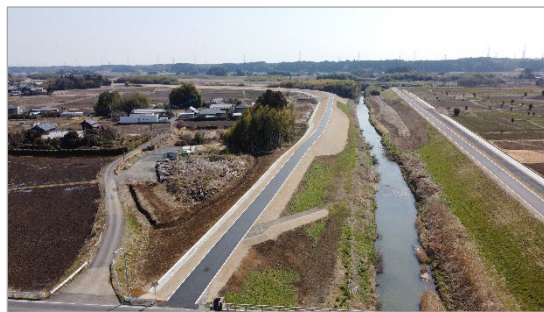
（堤防整備 茨城県）
