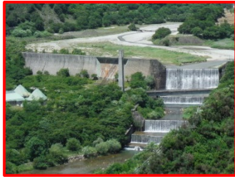
砂防施設の整備(足尾砂防堰堤)
