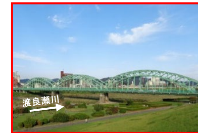
橋梁架替(中橋)
