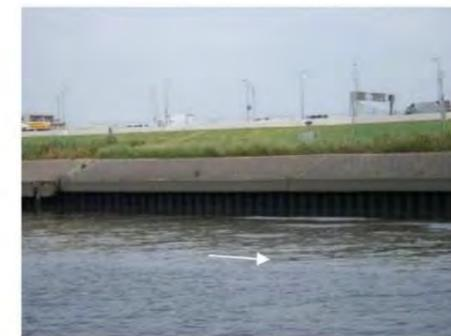
図 2-32 矢板護岸が整備された水際（13.0k 左岸）
