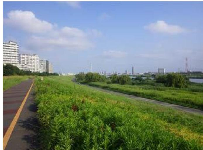
図 2-1920 緩傾斜堤防の例
