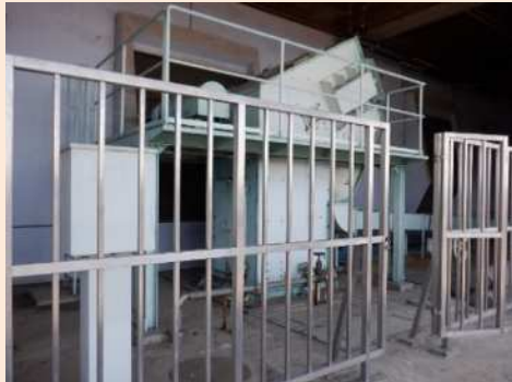
①ネット式除塵機 目幅: 10mm
