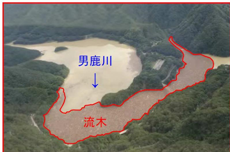
流木の捕捉状況(五十里ダム;H27.9 台風第18号時)
