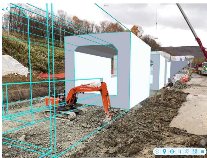
図 5-5 省力化・省人化－施工管理での活用
