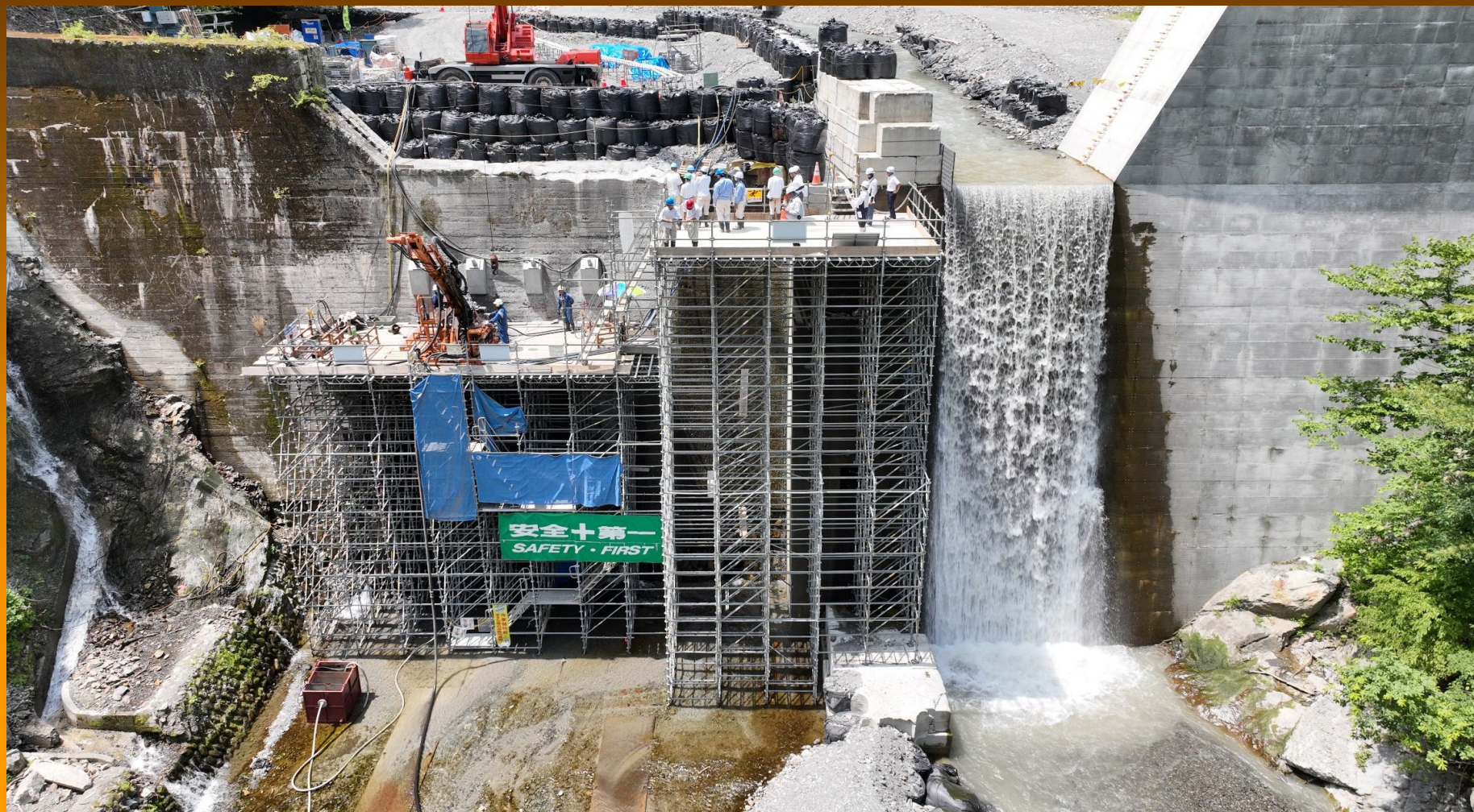
工事名：R4空谷砂防堰堤改築(2期)工事
