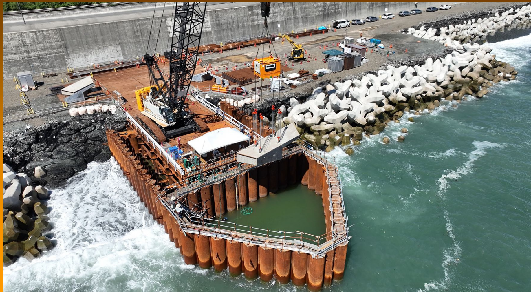
工事名：R3西湘海岸岩盤型潜水突堤整備工事
