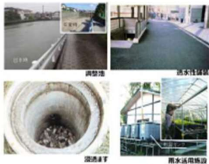
雨水貯留浸透施設の例
