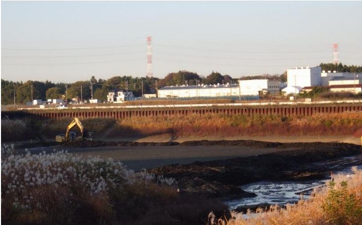
令和5年度実施北部第1調整池浚渫工事
