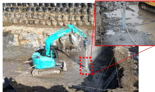
▲ダウンザホールハンマ工法による掘削状況
