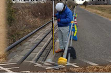
転落防止柵出来形確認
