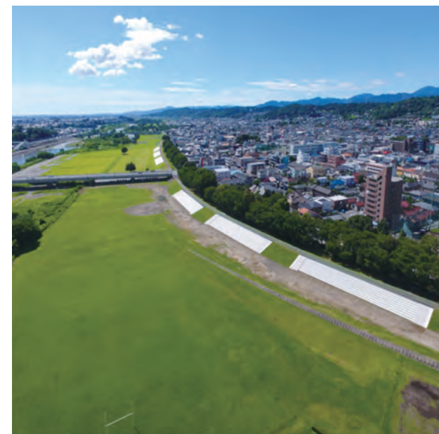
完成した階段護岸の状況(平成29年8月)
