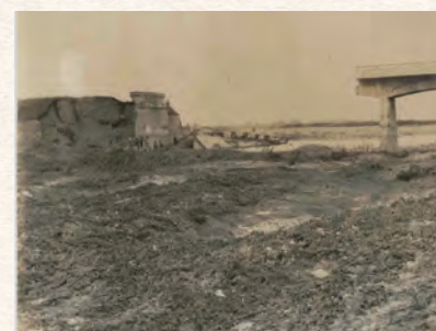
カスリーン台風で 落橋した烏川に架かる 岩倉橋（玉村町）
