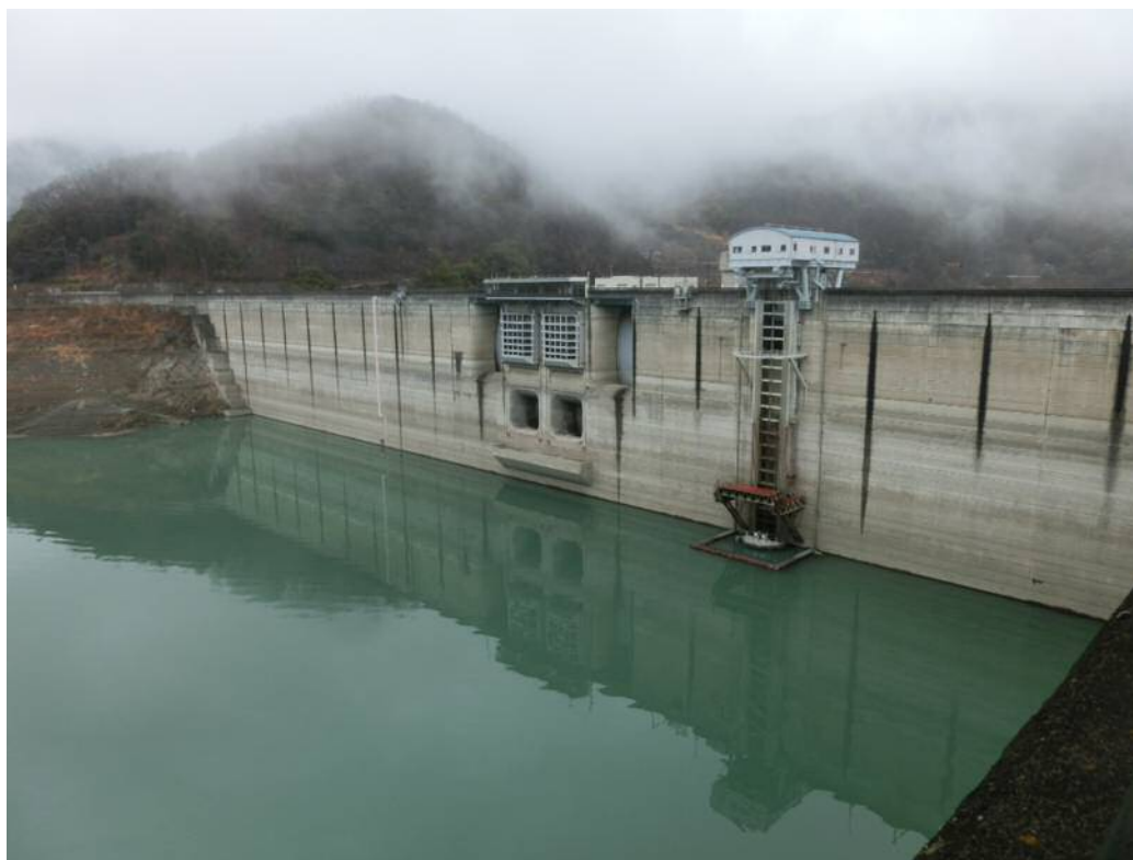
下久保ダムの貯水状況（令和6年2月21日撮影）
