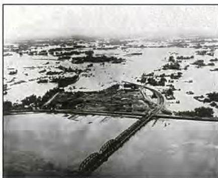
カスリーン台風時に堤防の決壊により浸水した栗橋(埼玉県久喜市)周辺の様子
