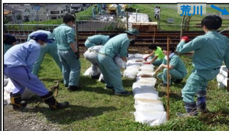
土のう設置作業【荒川右岸(足立区)】
