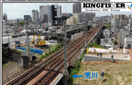
足立区側のパラペット(上流と下流)
