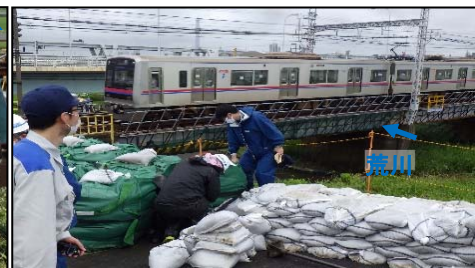
土のう設置作業【荒川左岸(葛飾区)】
