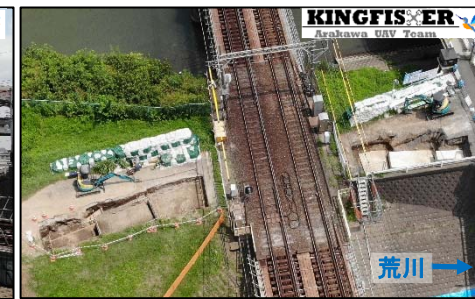
葛飾区側のパラペット(施工中)
