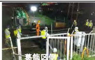
令和3年度は、堤防切り欠き部の土のう設置箇所にパラペットを施工
