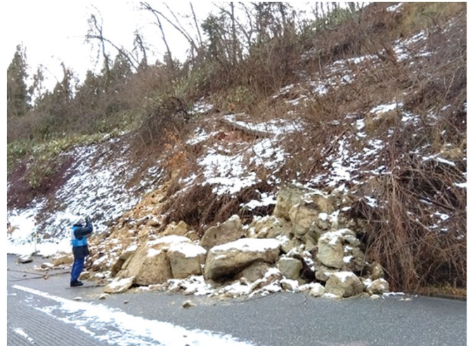
被災状況調査（崩壊した道路法面）【2月6日】
