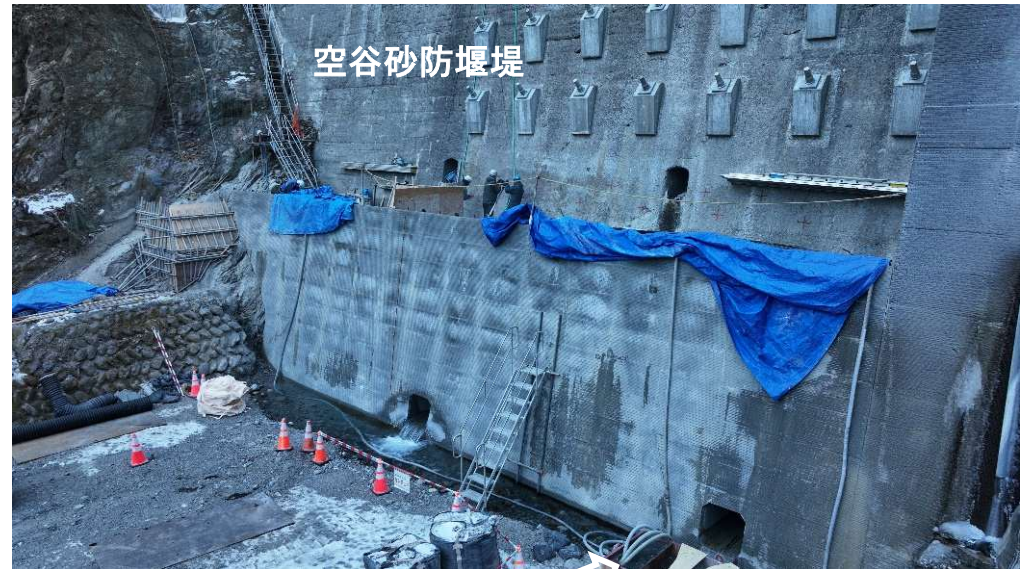
コンクリート堰堤（腹付け）施工状況
