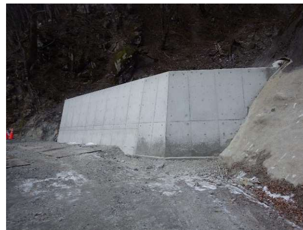
擁壁工施工状況【J地区：中島砂防堰堤上流】
