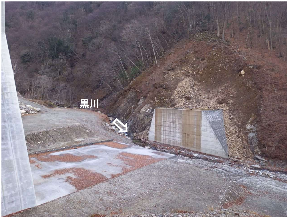
下流 右岸より本堰堤を望む（コンクリート堰堤工） （未着手）
