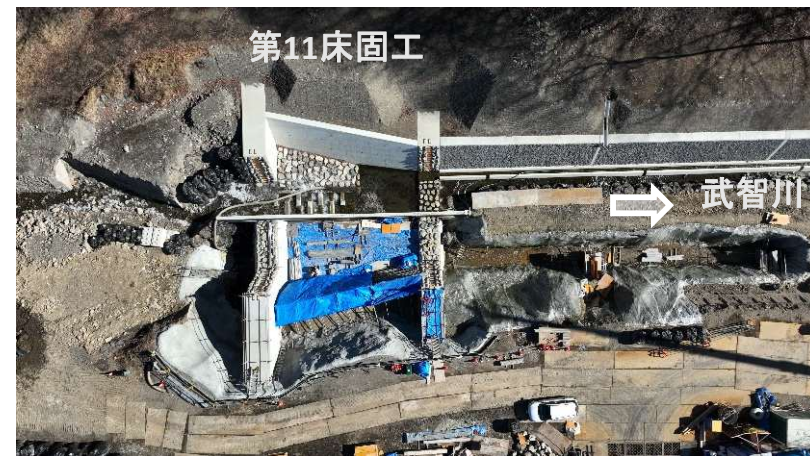
↑ 上空より施工箇所（第11床固工と流路護岸 作業土工）を望む
