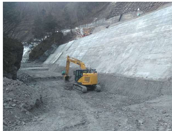
根固め床付施工状況【I地区：中島砂防堰堤下流】
