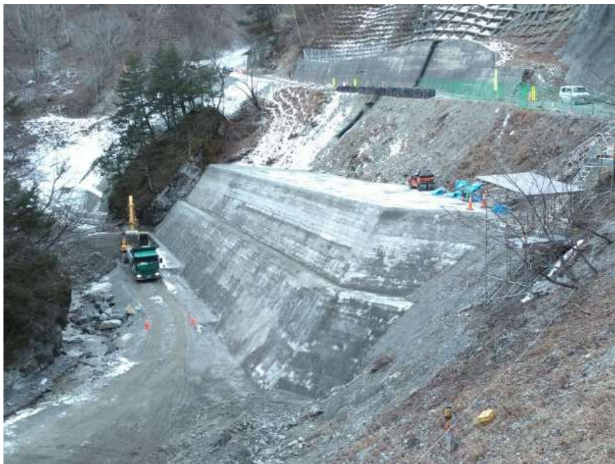
道路土工施工状況 【I地区：中島砂防堰堤下流】
