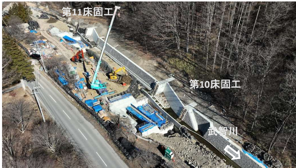
右岸上空より施工箇所を望む
