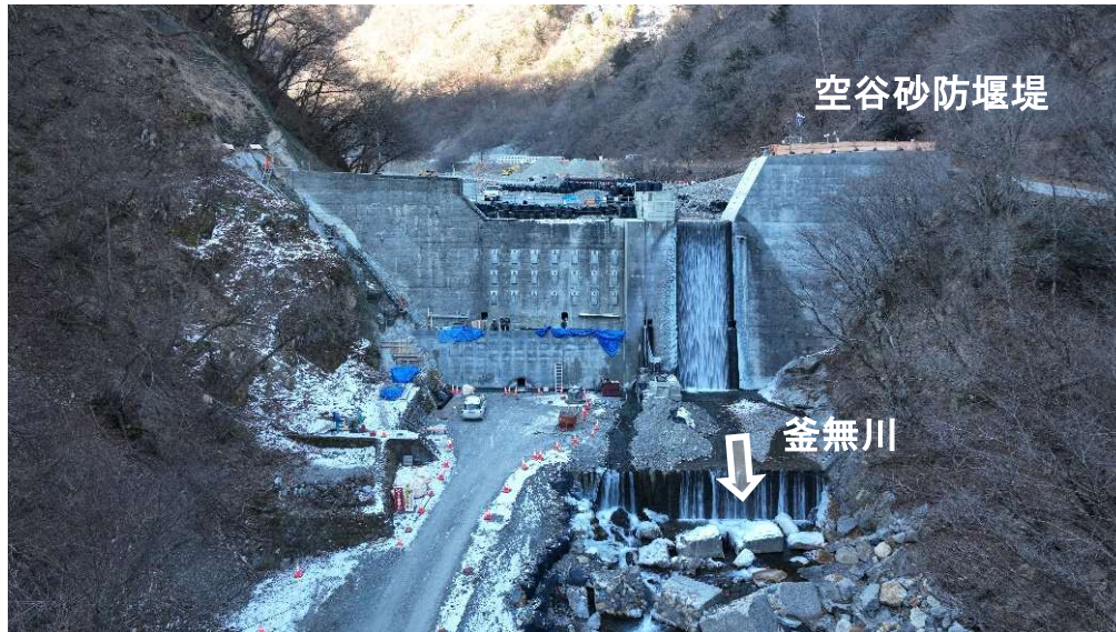
下流より本堰堤を望む（コンクリート堰堤工）
