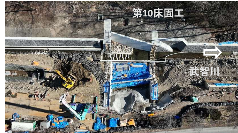
↑ 上空より施工箇所（第10床固工）を望む
