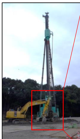
▲深層混合処理用重機
