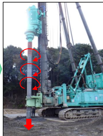
回転・攪拌しながらスラリーを注入
