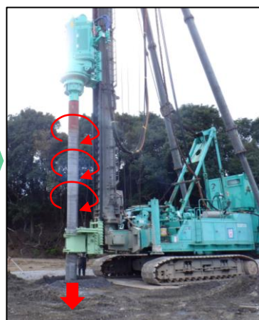
回転・攪拌しながらスラリーを注入
