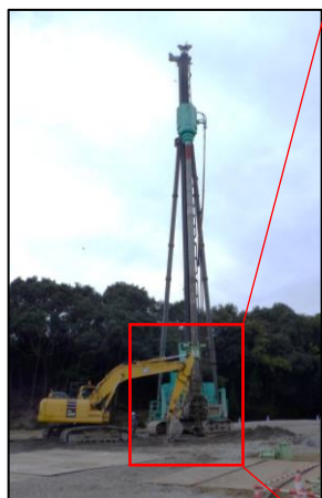
▲深層混合処理用重機
