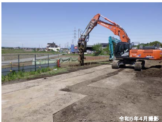
◀ 中層混合処理による地盤改良
