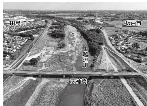
河道の掘削工事。坂戸市赤尾地区(2022年10月撮影)
