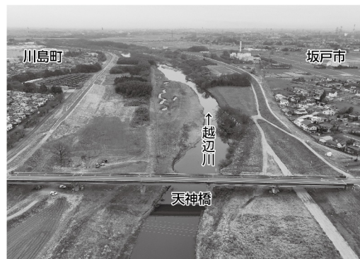
河道の掘削工事。坂戸市赤尾地区(2023年1月撮影)
