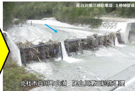
写真3: 流木、土砂捕捉効果事例
