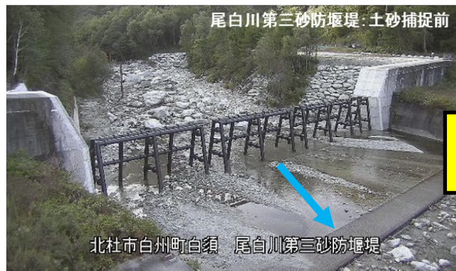
写真3: 流木、土砂捕捉効果事例
