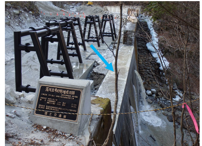
写真1: ①濁川三号砂防堰堤改築(流木止め設置等)
