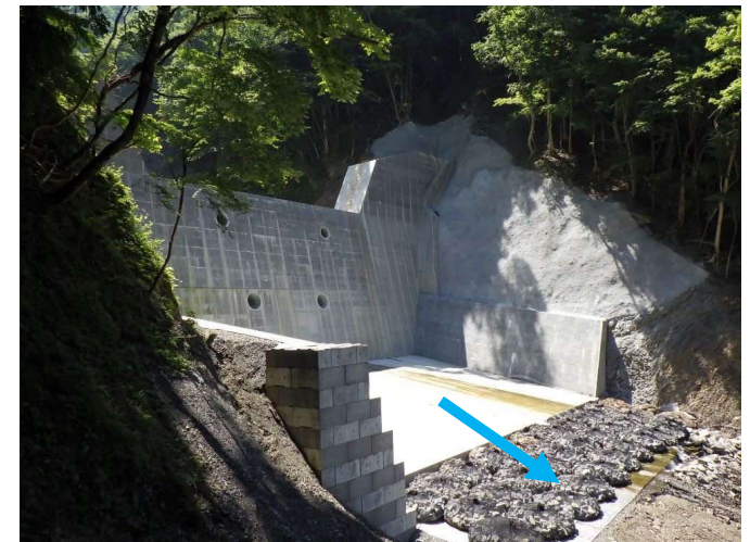
写真2: ②池の沢第三砂防堰堤
