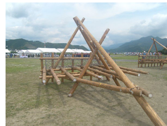
完成した水防工法
