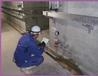
ダム堤体の点検 (堤体観測機器)
