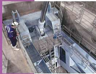
ゲートの点検 (コンジットゲート)
