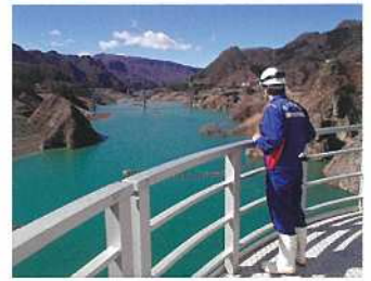
貯水池の点検 (湖面巡視)
