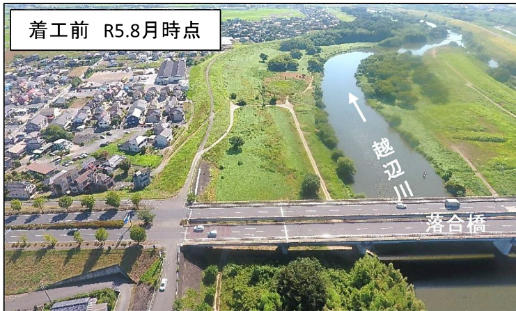
施工箇所(全景)
