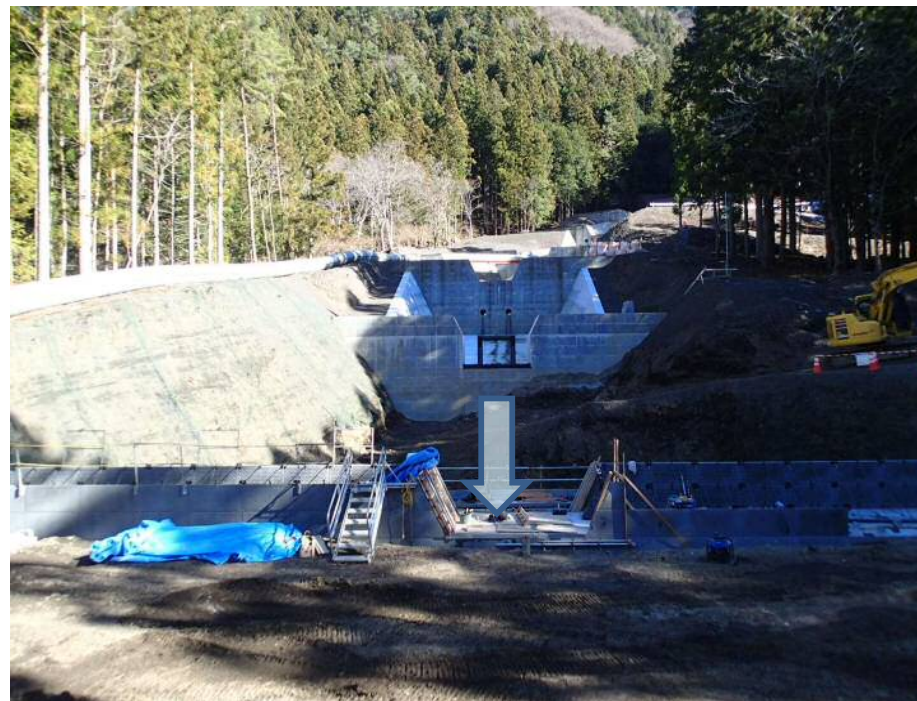
下流側より施工箇所を望む
