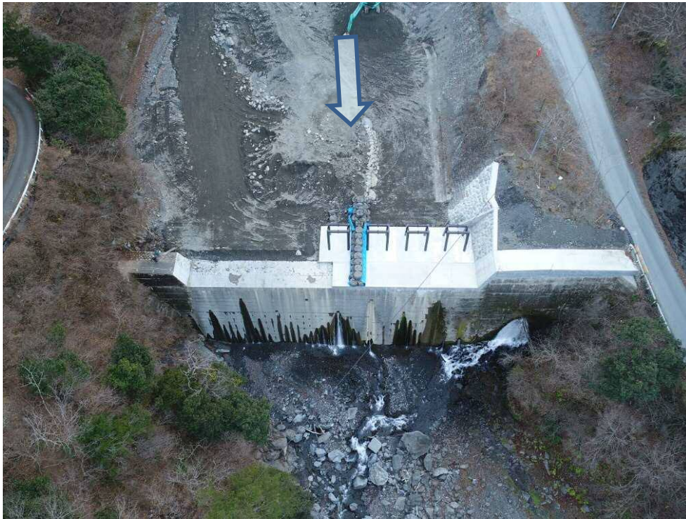
仲島工区 下流側上空より望む
