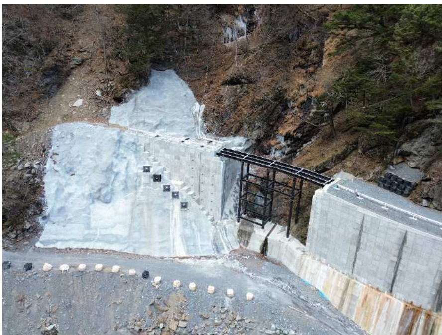
【下流側上空より施工箇所を望む】
