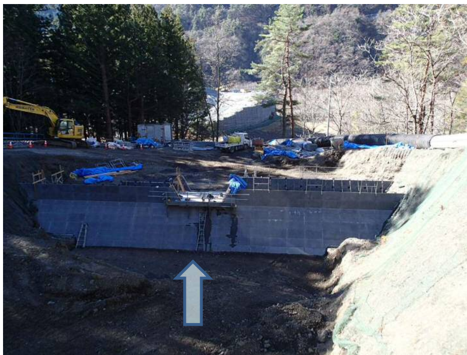
上流側より施工箇所を望む
