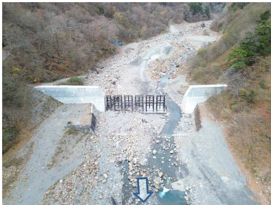
【下流側上空より施工箇所を望む】
