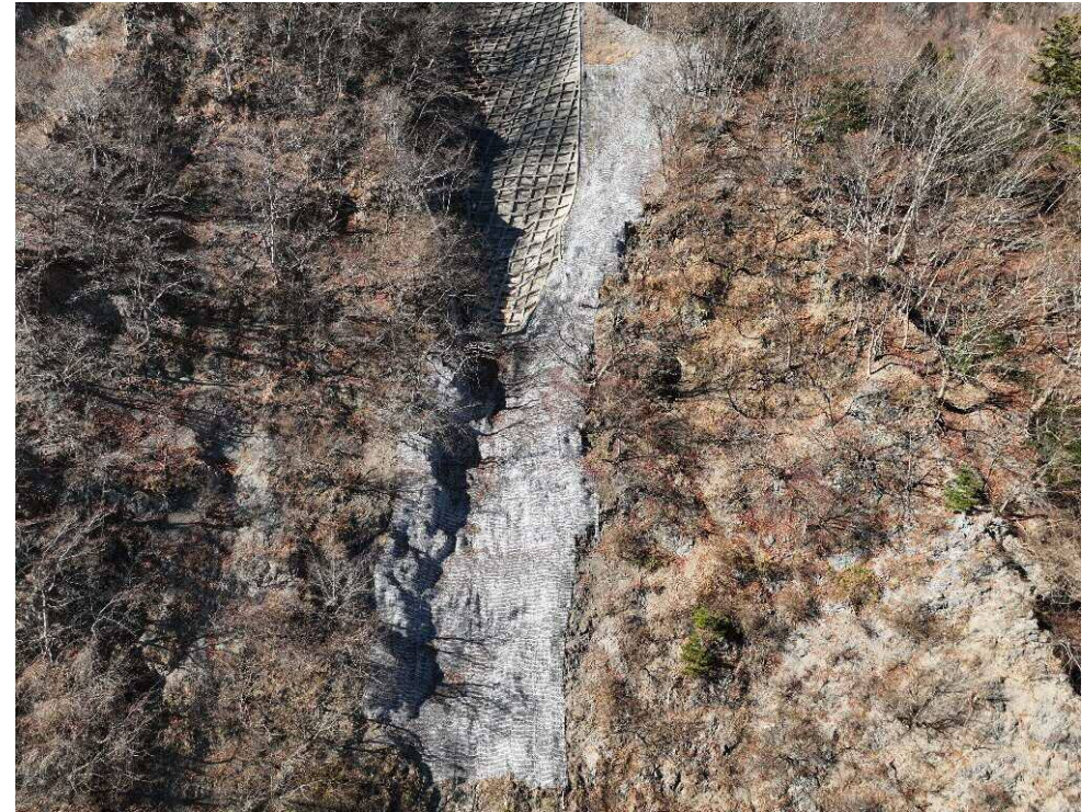
雪害防止網工（厚ネット）完了
