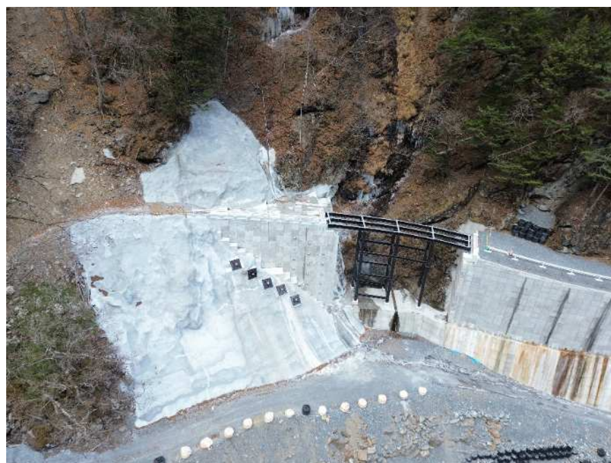
【右岸側上空より施工箇所を望む】
