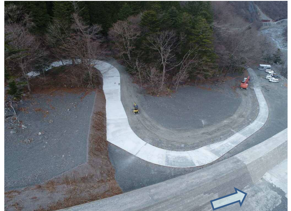
大春木工区 上流側上空より望む
