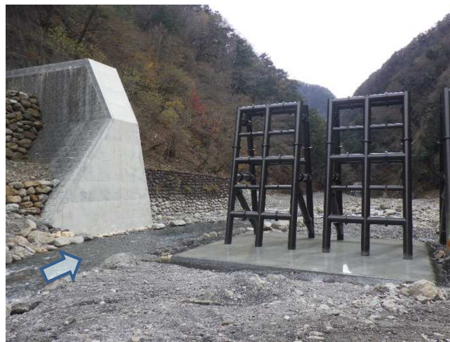
【上流側より施工箇所を望む】
