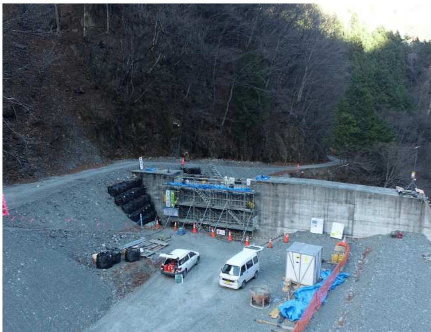
【上流側上空より施工箇所を望む】
