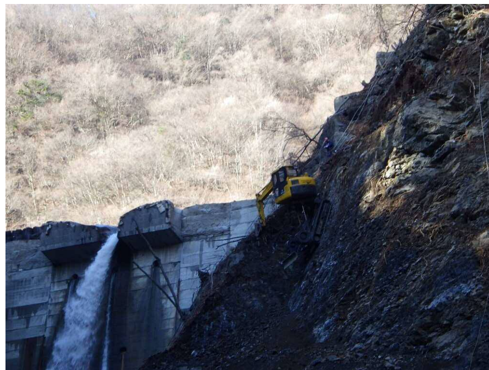
起点側より施工箇所を望む
