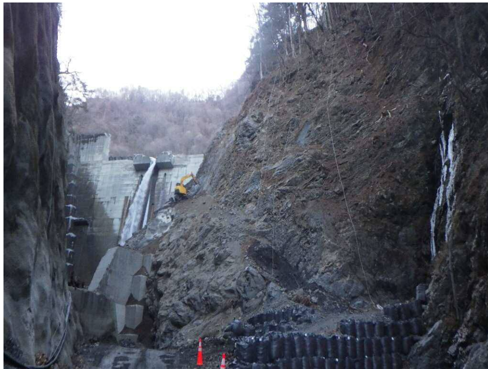
起点側より施工箇所を望む
