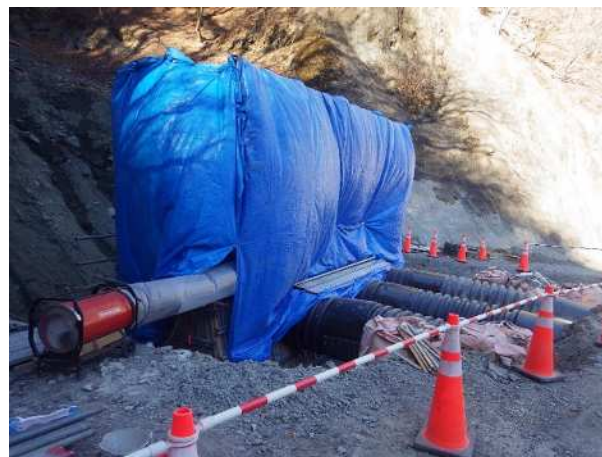
擁壁工施工状況【J地区：中島砂防堰堤上流】
