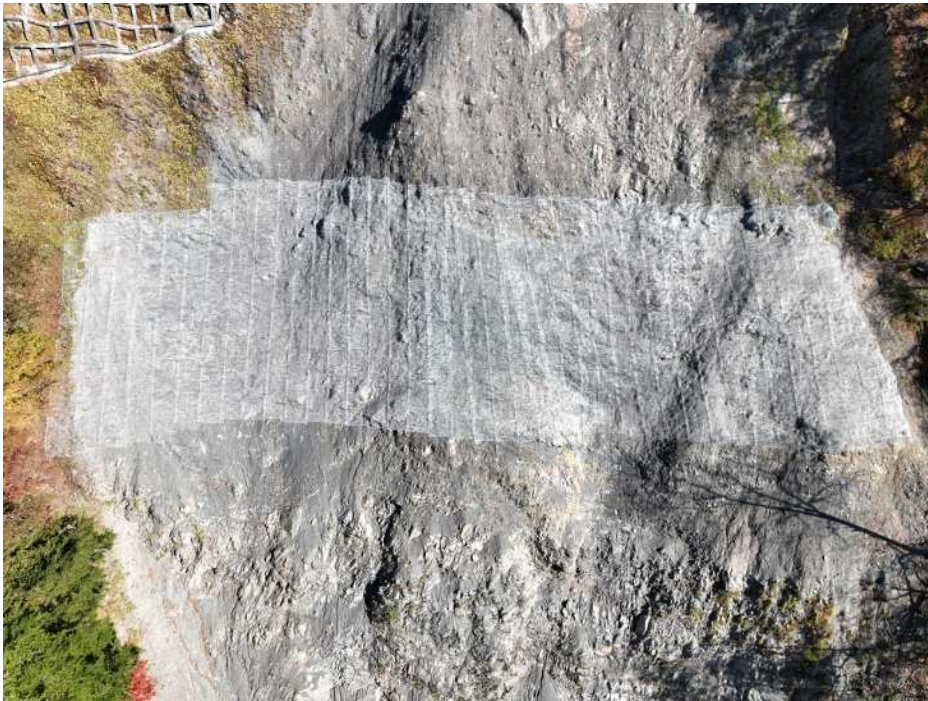
落石防止網工 施工完了
