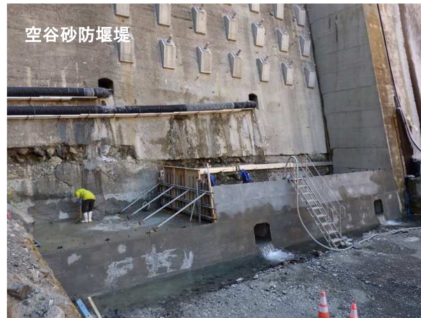
コンクリート堰堤（腹付け）施工状況
