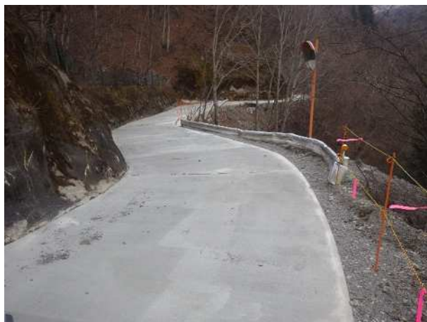
舗装工 【中川地区】 完了
