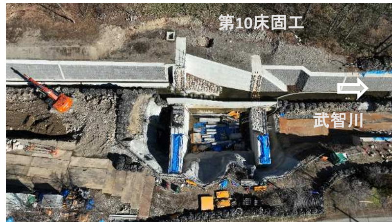
↑ 上空より施工箇所（第10床固工）を望む
