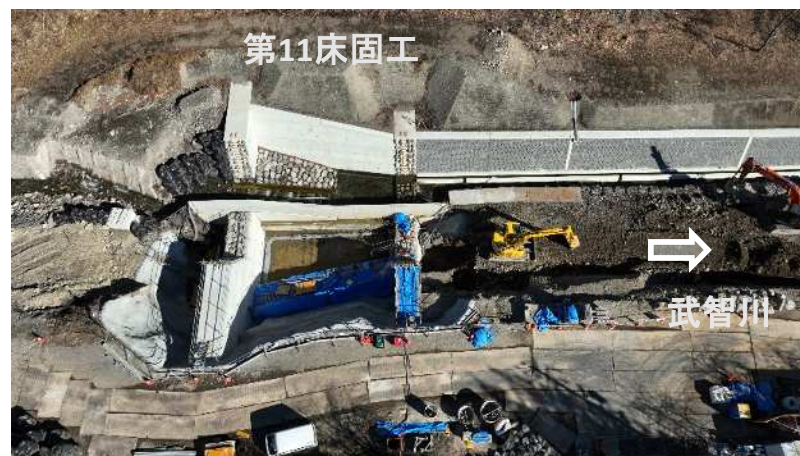
↑ 上空より施工箇所（第11床固工）を望む
