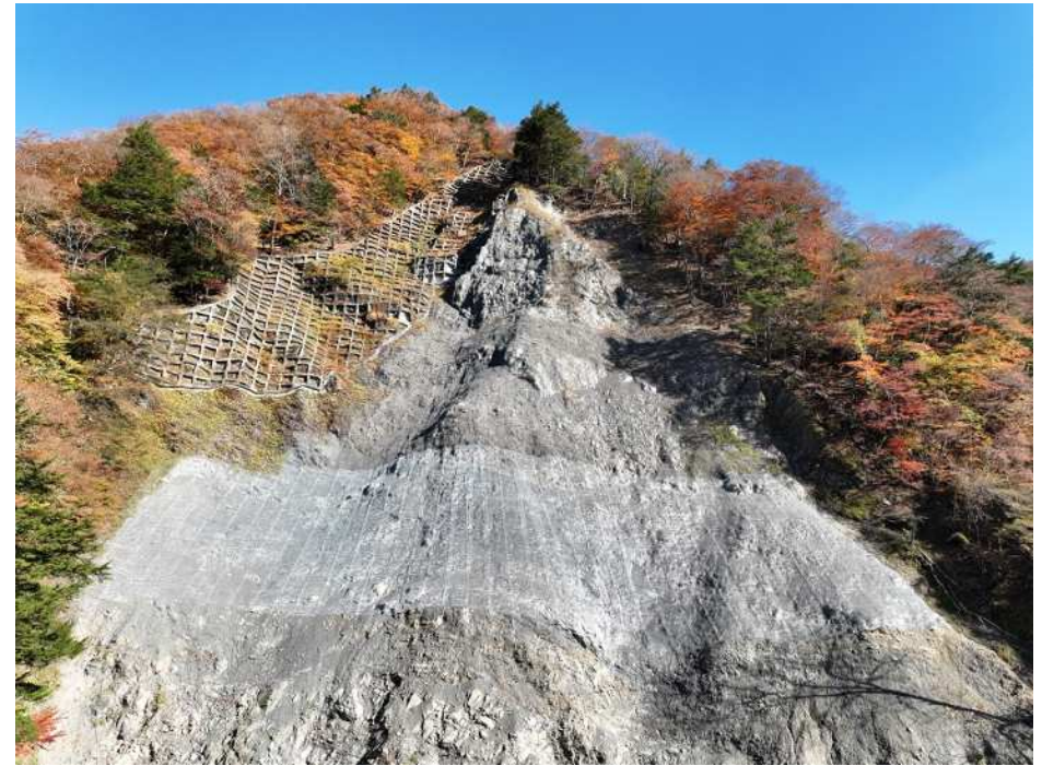
落石防止網工 施工完了
