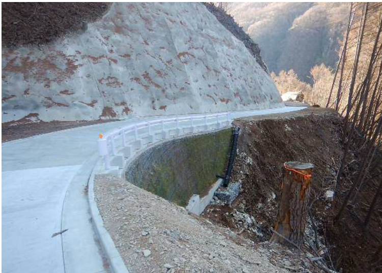
法面工、コンクリート舗装の状況
