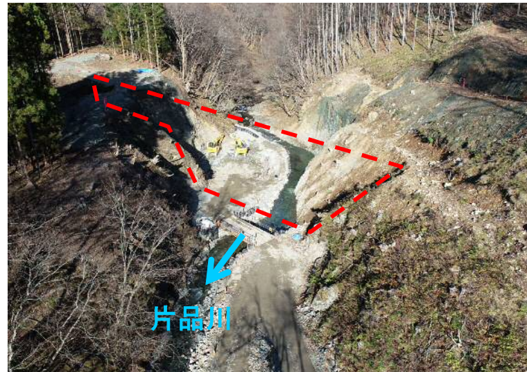
本体掘削状況
