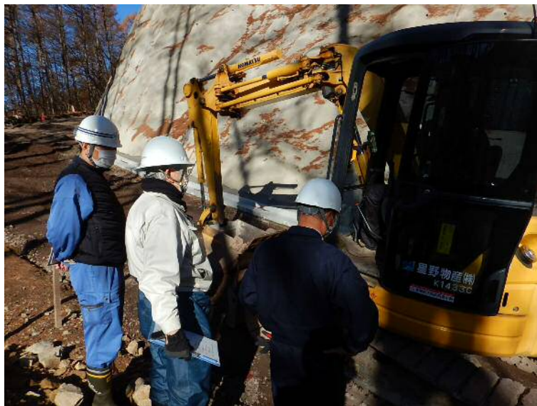
R4 栗原川第三砂防堰堤管理道路工事
