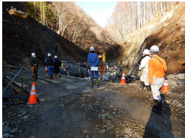
R5 片品上流第二砂防堰堤工事
