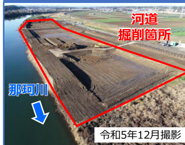
④河道掘削 （水戸市中河内地区）
