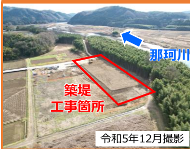
①堤防（霞堤）整備 （那須烏山市下境地区）
