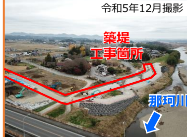
⑦堤防整備 （城里町下坪地区）
