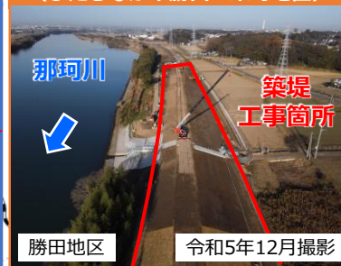
⑥堤防整備 （ひたちなか市勝田・栄町地区）
