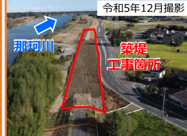
⑨堤防整備 （水戸市大野地区）
