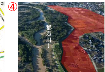
都幾川左岸6.5k付近
