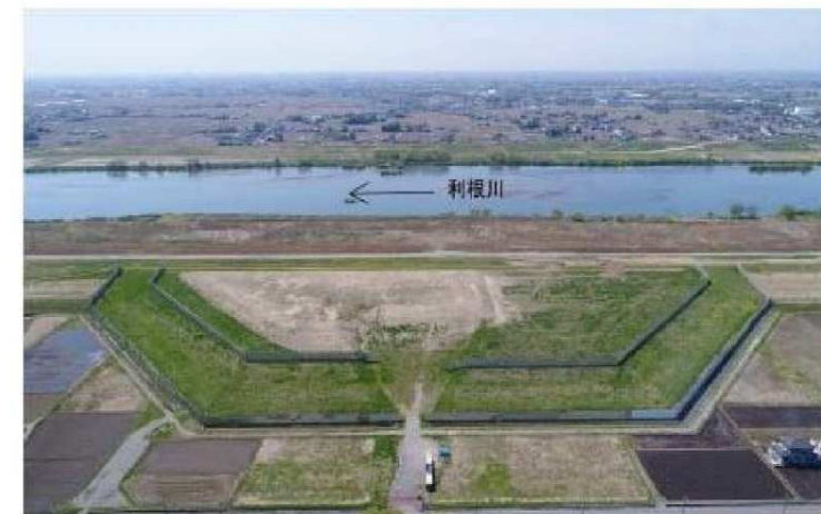
栄地区広域避難地(埼玉県加須市)
