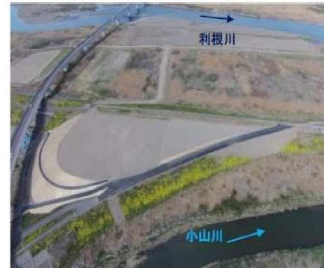
下高島地区(埼玉県深谷市)
