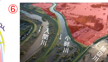
越辺川右岸0.0k付近
