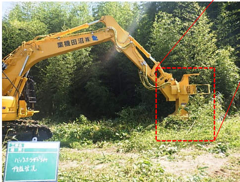
▲伐採工法の紹介
