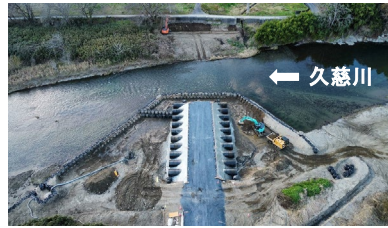
▲施工途中の渡河施設
