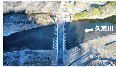
▲完成した渡河施設
