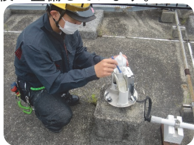
水文・水理観測機器の点検補修
