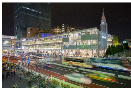
ターミナル化（バスタ新宿）（写真提供：東京国道事務所）
