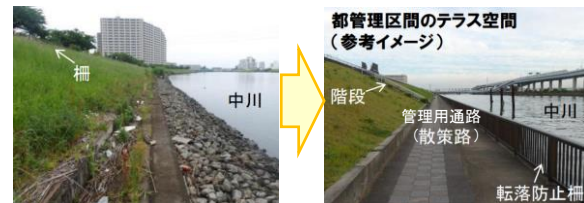
整備前の状況 (R6~R14) 整備後のイメージ
