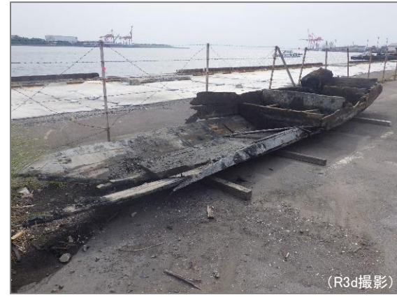
沈船(木造船)の撤去状況
