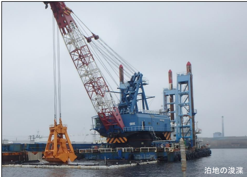
令和3年 施工状況
