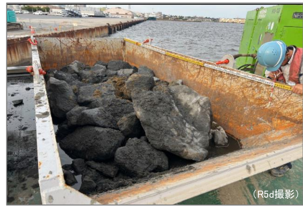
捨石の撤去状況
