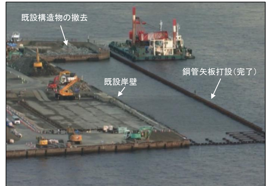
令和5年 施工状況
