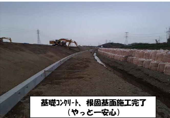
基礎コンクリート、根固基面施工完了 (やっと一安心)
