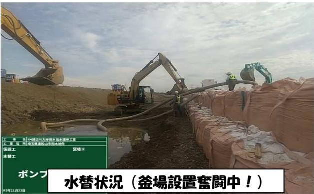
ポンプ 水替状況 (釜場設置奮闘中!)
